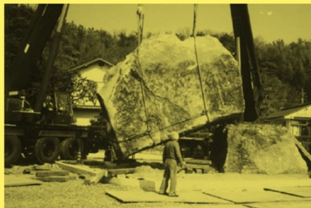
※ 組み立て工事：1994(平成6)年 来待ストーンは1996(平成8)年開館
